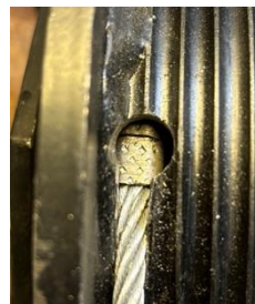
Fig 2 Lininfästningen med presslås
