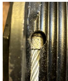
Abb. 2 Drahtseilende mit montiertem Pressverschluss
